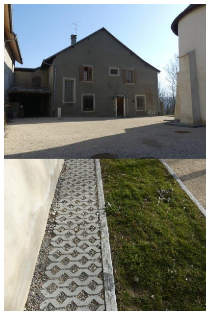
Béton alvéolé perméable en pied de mur et herbe
