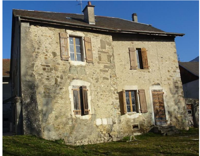
L'enduit usé révèle la structure des murs anciens : pierres locales pour les murs, pierre calcaire blanc pour les encadrements d'ouvertures
