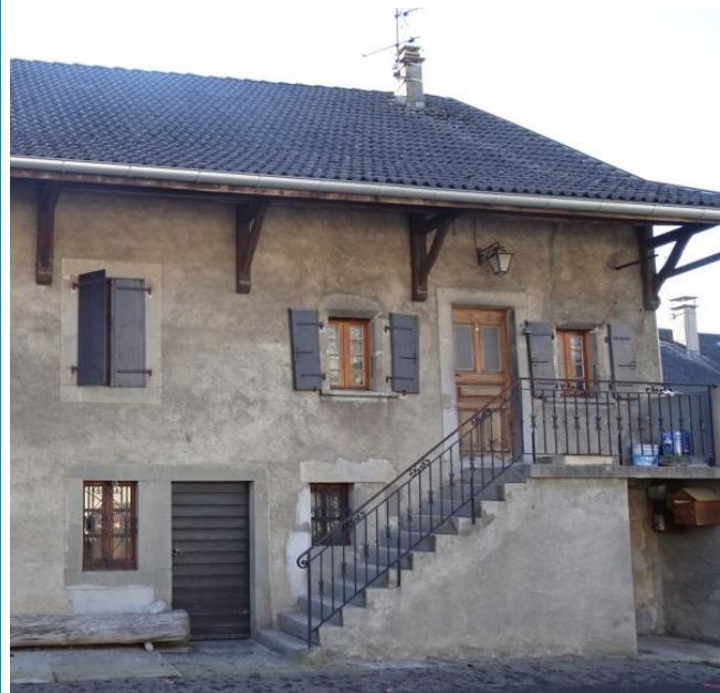
Passées de toit prononcées des anciennes fermes, reposant sur des consoles
