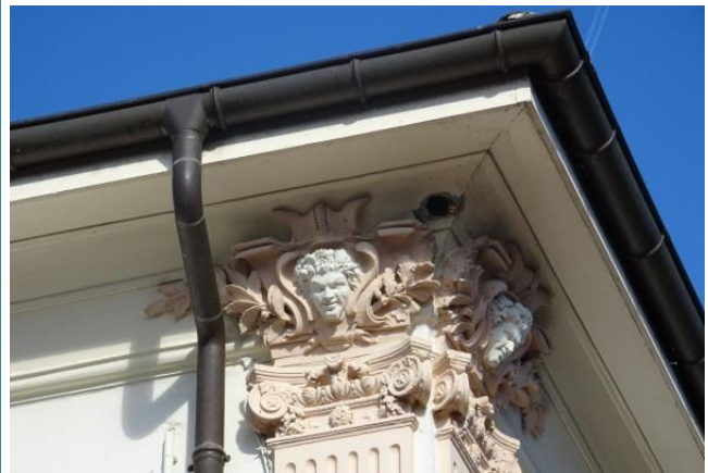
Passées de toit des maisons de maître, ici coffrées, planches larges et couvre-joints
