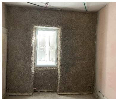
projection de l'isolant chaux chanvre
