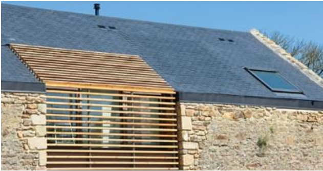
Solaire thermique invisible (sous ardoises) Thermoslate_solar_system
