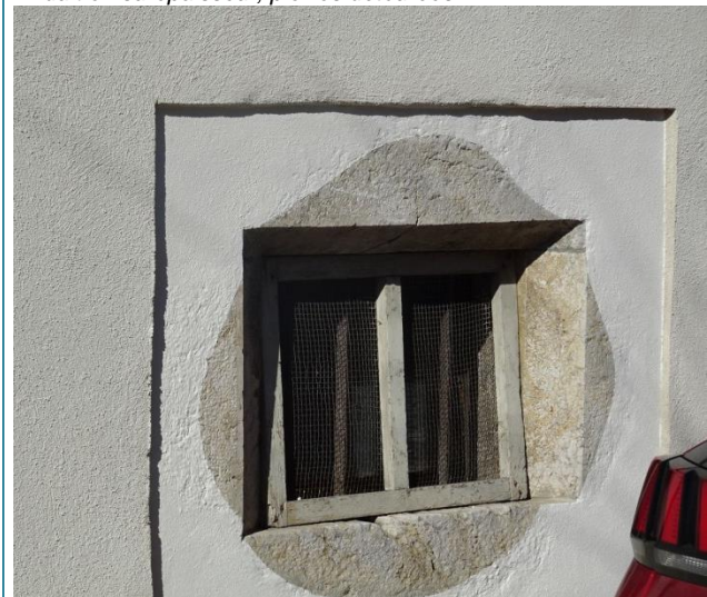
Enduit en surépaisseur
