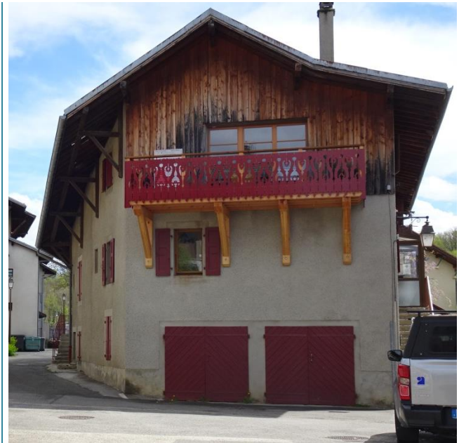
Agrandissement du balcon, en largeur et en profondeur, rajout de consoles pour supporter le nouveau balcon.
