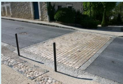
Exemple : utilisation de galet, dalles et béton désactivé
