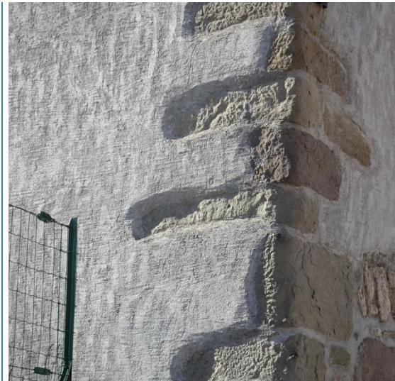
Enduit en surépaisseur, pierres détournées
